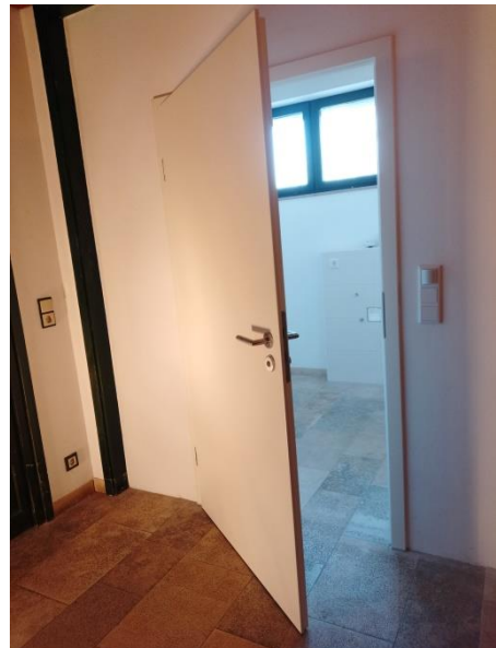
Bauphasen: Der Durchgang wurde auf Türgröße verkleinert, Wasser- und Elektroinstallationen vorgenommen, nach dem Fließen und dem Einbau der Tür fehlt nur noch WC und Waschbecken
