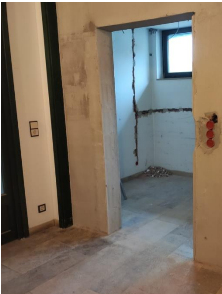
Bauphasen: Der Durchgang wurde auf Türgröße verkleinert, Wasser- und Elektroinstallationen vorgenommen, nach dem Fließen und dem Einbau der Tür fehlt nur noch WC und Waschbecken
